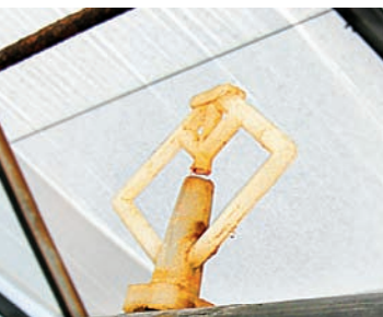
С помощью форсунки вода превращается в туман
