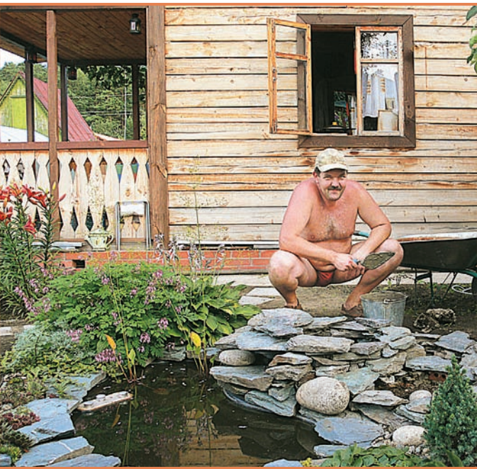
Вокруг водоема из плитняка выложили карманы для посадки декоративных растений
